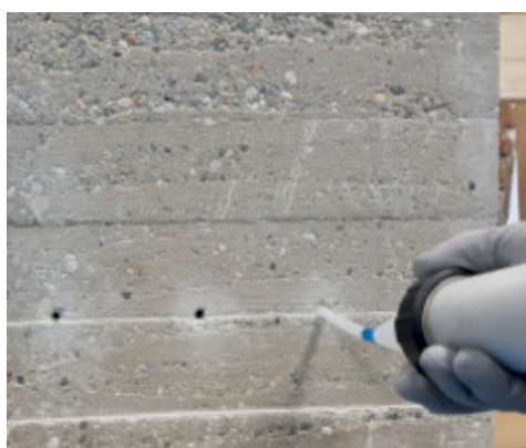
Realizzazione barriera chimica in parete in CLS
