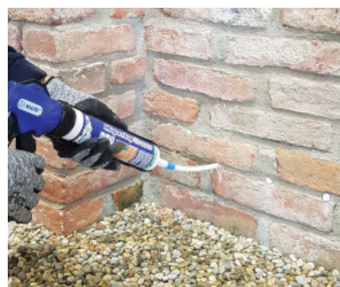
Estrusione della crema in cartuccia riempiendo ciascun foro
