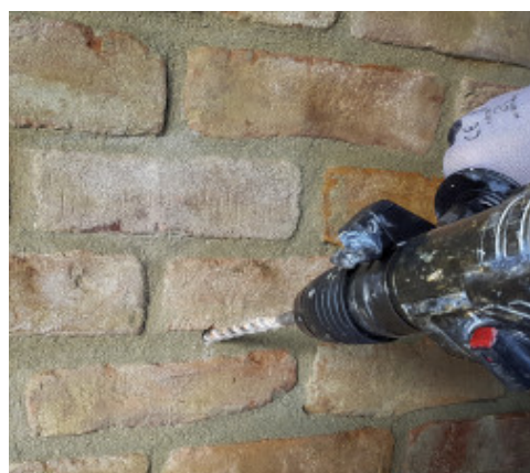
Realizzazione dei fori
